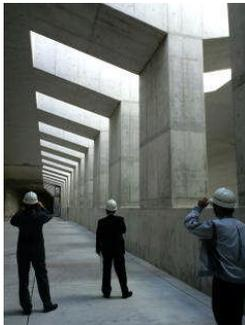
♣貝塚公園を分断する小塚山トンネルでは、丘の両側からトンネルの枠を徐々に押し込む実験工事中。騒音対策で工事現場全体をコンクリートの建屋で覆う。工事現場そばで縄文時代の遺跡が発見されたが、埋め戻されている。
